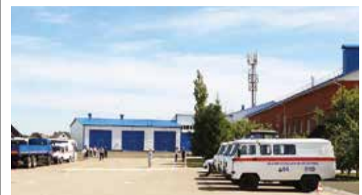
Новое здание газового участка построено за 5 месяцев
