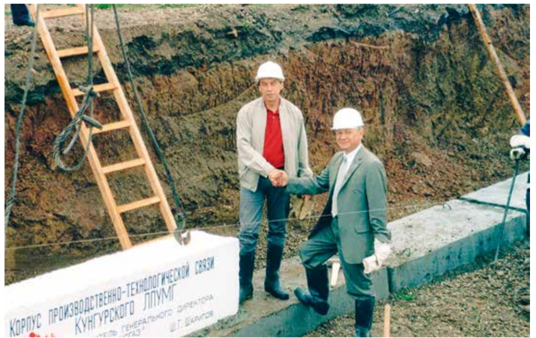
Закладка фундамента корпуса производственно-технологической связи Кунгурского ЛПУМГ, 2004 г.
