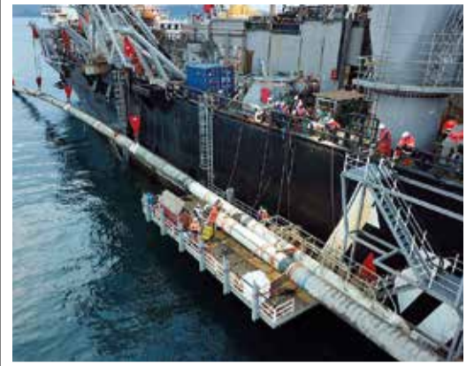
Соединение морской и наземной частей газопровода «Турецкий поток»
